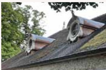
Lucarne sur le versant du toit
