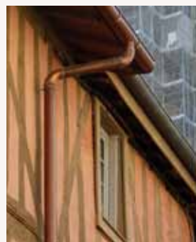
Gouttière en cuivre
