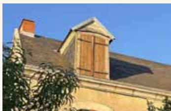
Lucarne en aplomb de la façade
