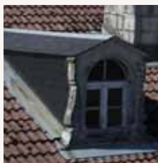
Lucarne engagée en zinc
