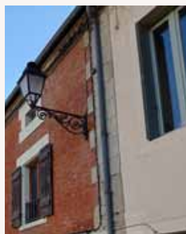
Gouttière en zinc
